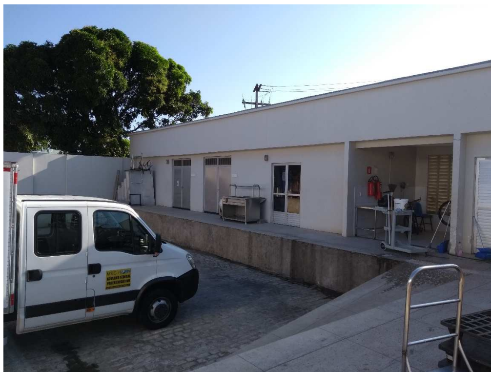
Figura 22: Reforma no setor de apoio (externo). Fonte: Acervo próprio do autor, 2018
