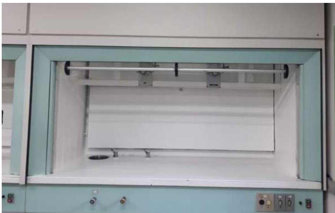
Figura 20: Capela após manutenção.
