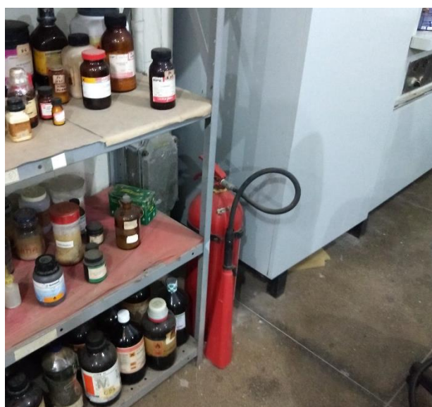
Figura 16: Localização de extintor em laboratório. Fonte: Acervo do próprio autor.
